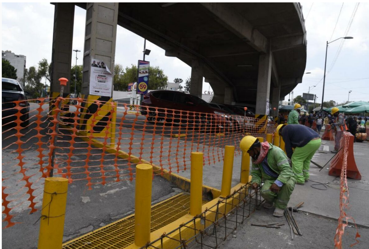
Trabajadores de la CDMX realizando obra pública.
